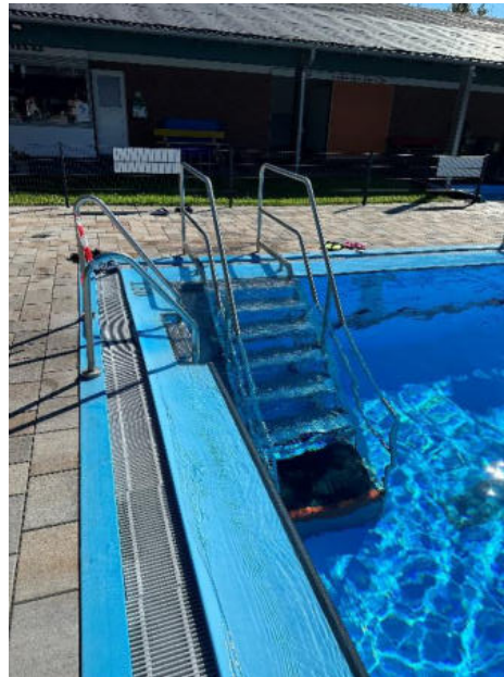
Einstiegstreppe Freibad Batz
