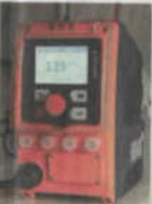
Das Messgerät zeigt, wieviel Eisenchlorid-Lösung schon eingebracht wurde.
