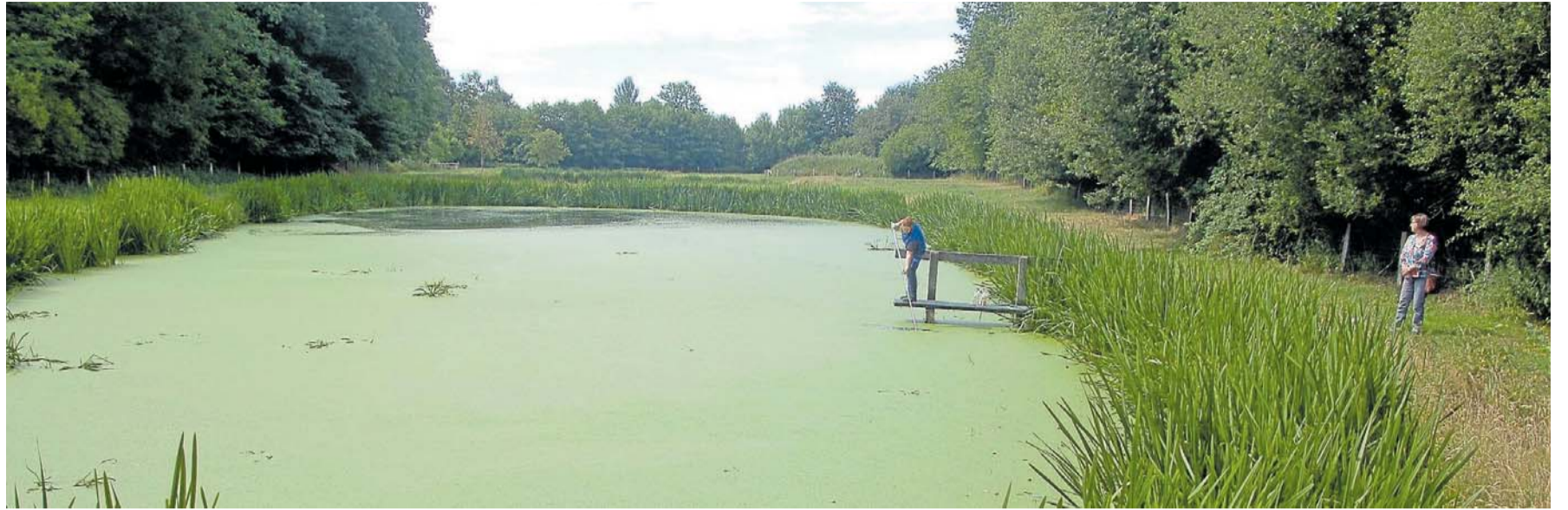
In die Klärtechanlage in Sören, hier entnimmt Leah Endling vom Abwasserzweckverband eine Probe, wird eine Anlage eingebaut, in der das Phosphat herausgefiltert wird. FOTO: FRANK SCHEER
